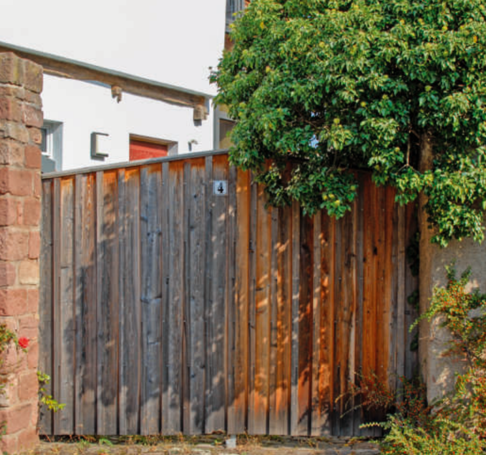
Hoftor aus Holz / Stahltore mit Holzverschalung
