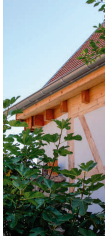
Traufgesims durch Verkleidung als Traufkasten
