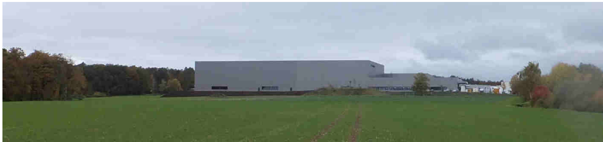
Foto vom Ortstermin: westlich der Anlage liegendes Betriebsgebäude
