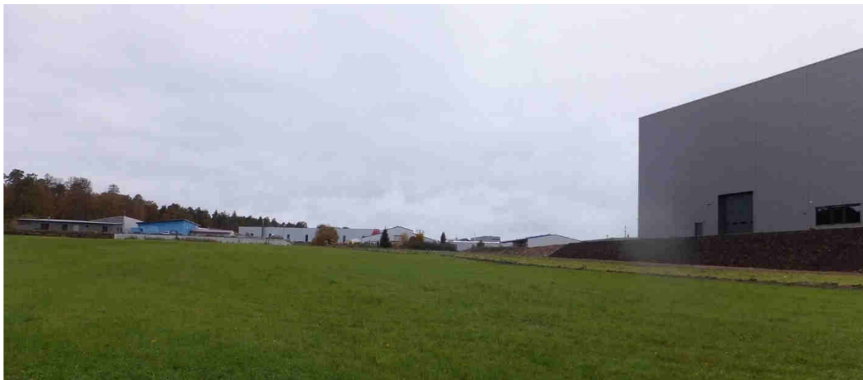
Foto vom Ortstermin: südwestlich der Anlage liegendes Betriebsgebäude
