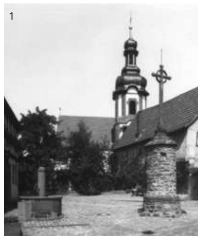
Abb. 1 Der Kirchplatz als räumliche Mitte (1990) mit Pfarrkirche und Kirchhofmauer, dem ehem. "Gasthaus zur Sonne" (links im Bild) und dem "Frühmessnerhof". Die Platzmitte mit dem steinernen Sühnekreuz und Brunnen.
